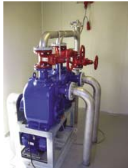
Zelfaanzuigende centrifugaalpomp met riemaandrijving.
