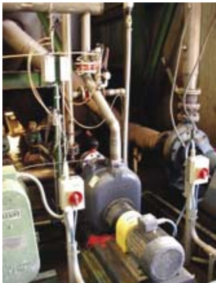
Zelfaanzuigende centrifugaalpomp in bedrijf.
